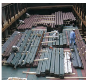
鋼材積み込み
