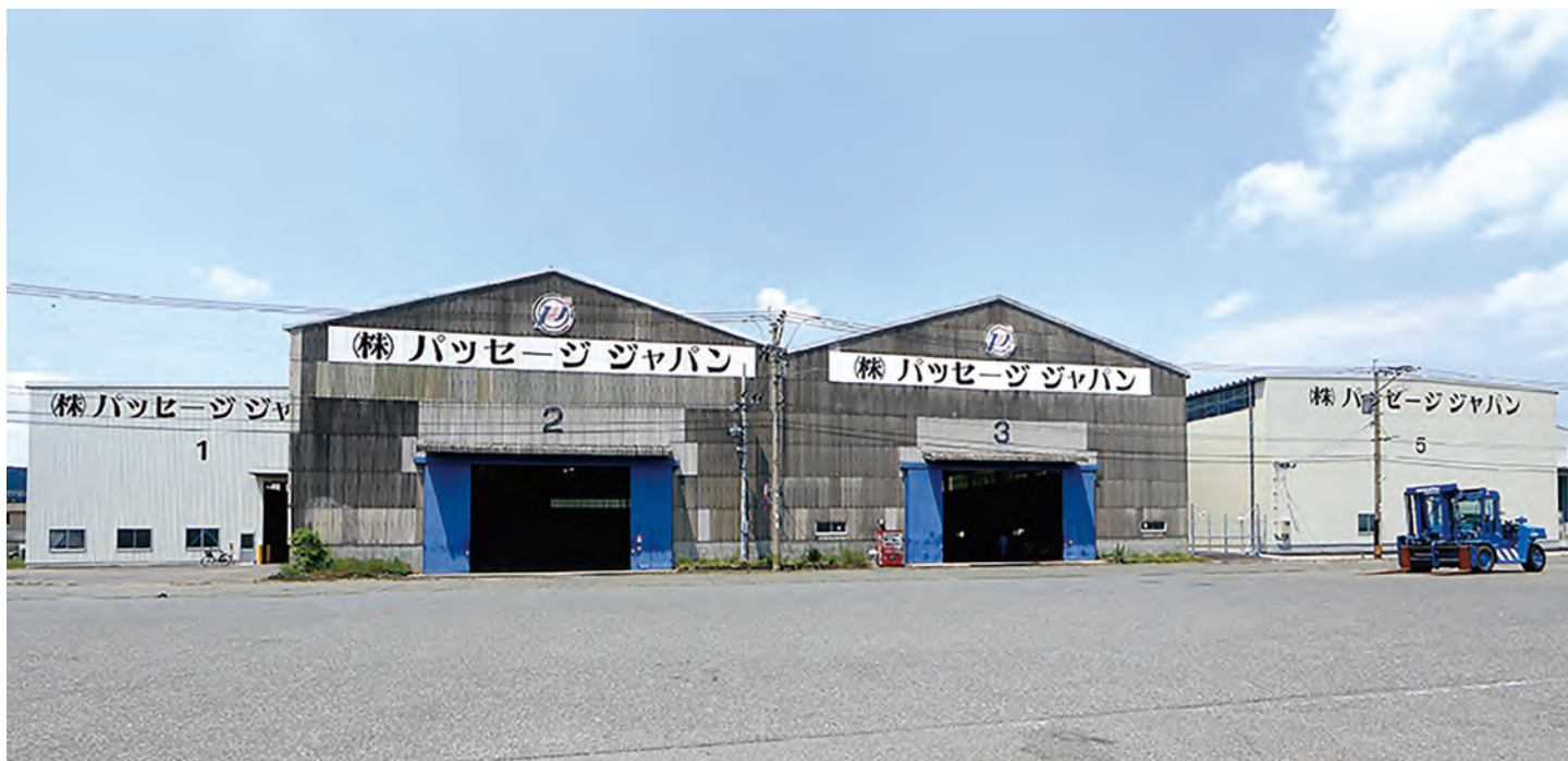
自社倉庫(鋼材倉庫)
